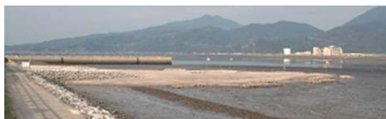
熊本港「東なぎさ線」：人工護岸前面に「なぎさ線」を造成して地形の連続性と生態系の連続性を創出
