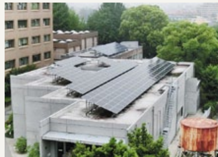
学生食堂(FORICO)屋上 30kW
