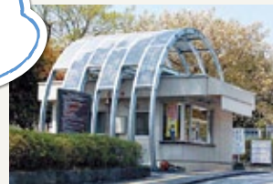
ソーラードーム
