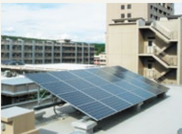
工学部研究棟Ⅳ 5kW
