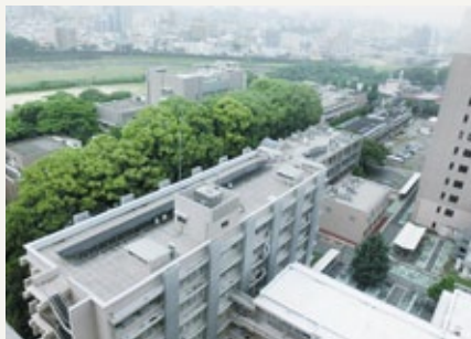
研究実験棟屋上 50kW
