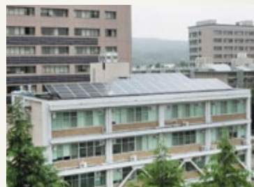
共用棟黒髪2 26kW
