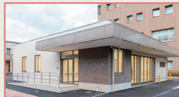
マルチ・トリアージ棟 (MT棟) 令和4年1月完成
