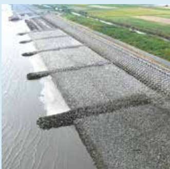
防災と環境に配慮した海岸堤防(玉名市横島町)。消失した生物生息場が回復するとともに景観・親水機能も向上
