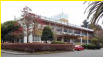
(上)改修後 (右)改修前
