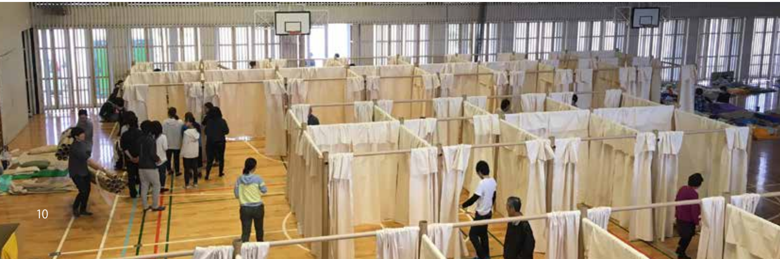
宇土小学校体育館で、紙管間仕切りを設置している様子。避難者の方がすでにいる体育館だったため、声かけをして少しずつ設置した
