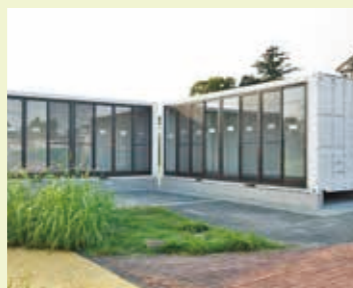
建設中の益城町サテライトラボ
