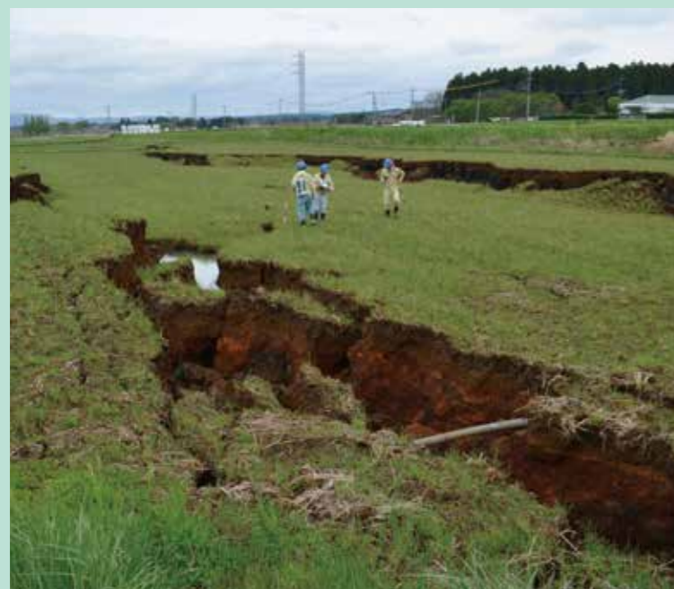
地表(地割れ)と地表水および地下水状況の調査
