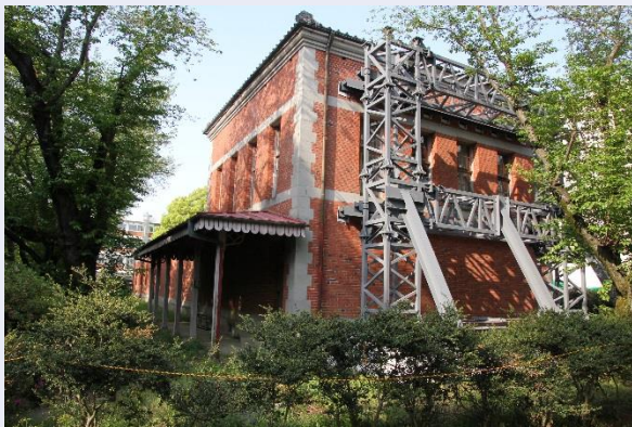
化学実験所の応急対応補強 (2018/4)
