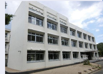
復旧工事が完了した附属小学校の管理棟（2018/6）
