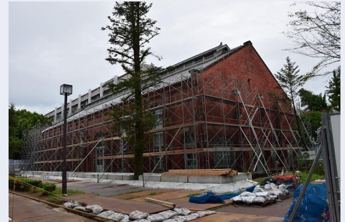
コンクリートの土台にアンカー（2017/9）
