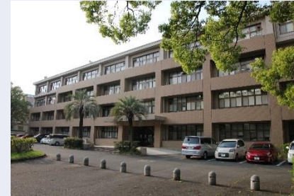
復旧工事が完了した建物
