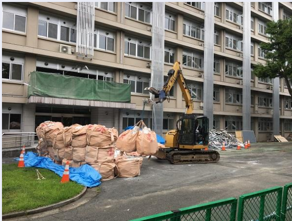
内部の撤去物の搬出（2017/7）
