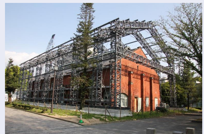
応急対応補強のための一次工事完了（2017/10）
