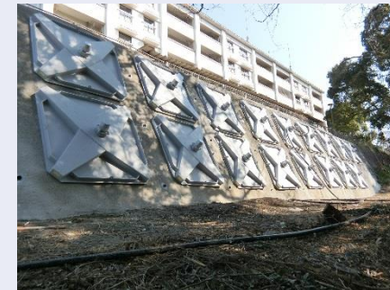
復旧後の擁壁
