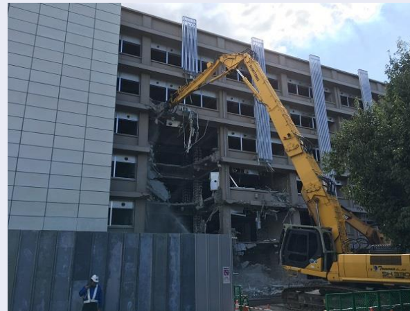
重機での外壁取り壊し工事開始（2017/9）
