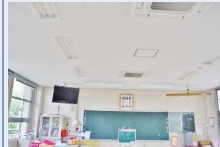
復旧後の教室の天井
