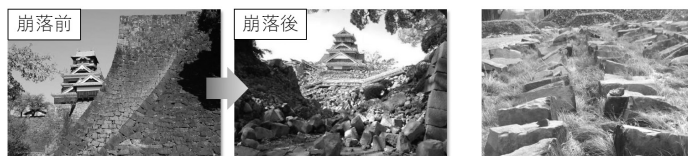
図1 崩落前後の熊本城の石垣と石置き場に移動された崩落石材
